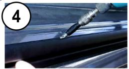
Anschrauben der Universalschiene mit den mitgelieferten Selbstbohrschrauben 3,9x 16 mm.
