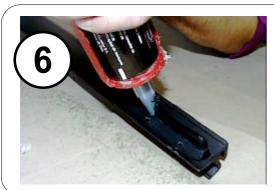
Sikaflex 252 auf die gereinigte Schiene auftragen, dazu Spitze auf Größe 2 schräg anschneiden. Kartusche senkrecht halten und gleichmäßig auftragen. Jede Bohrung mit einem Tropfen Sika abdichten. Schiene mit schwarzen VA Schrauben 3.9mm anschrauben.
